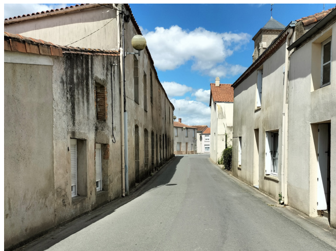
8/ Effet couloir de la rue de la Promenade et absence de valorisation des seuils bâtis
