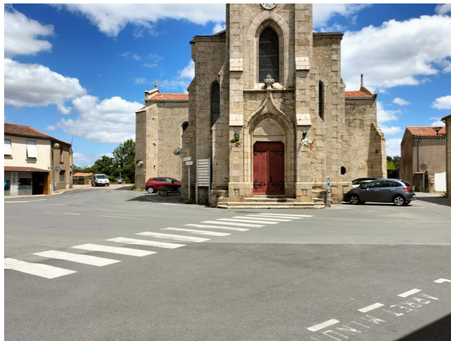
1/ Entrée principale de l'Eglise donnant directement sur la voirie, absence de parvis
