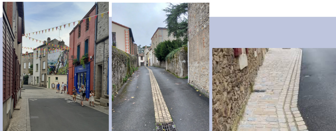
Pieds de façades pavés se prolongeant sur la chaussée afin de casser l'effet couloir et agir sur la vitesse de déplacement des automobilistes + création d'un caniveau central
