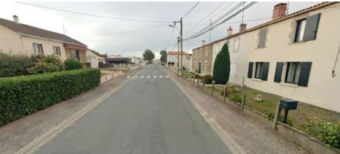
Voirie, 580 000 € dont la réfection des eaux pluviales Rue de la Promenade, 470 000 € (opération encore à l'étude)
